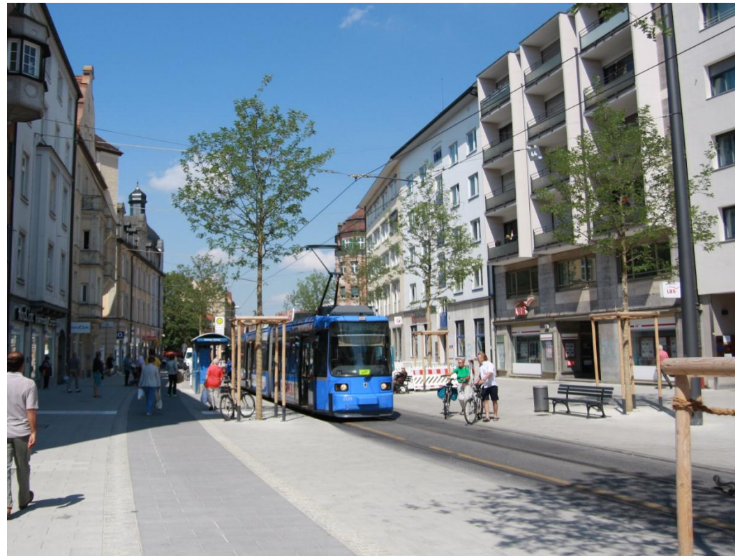
Situation nach dem Umbau
