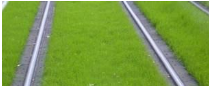
Bsp.: Rasengleis mit Schienenkammergelementen
